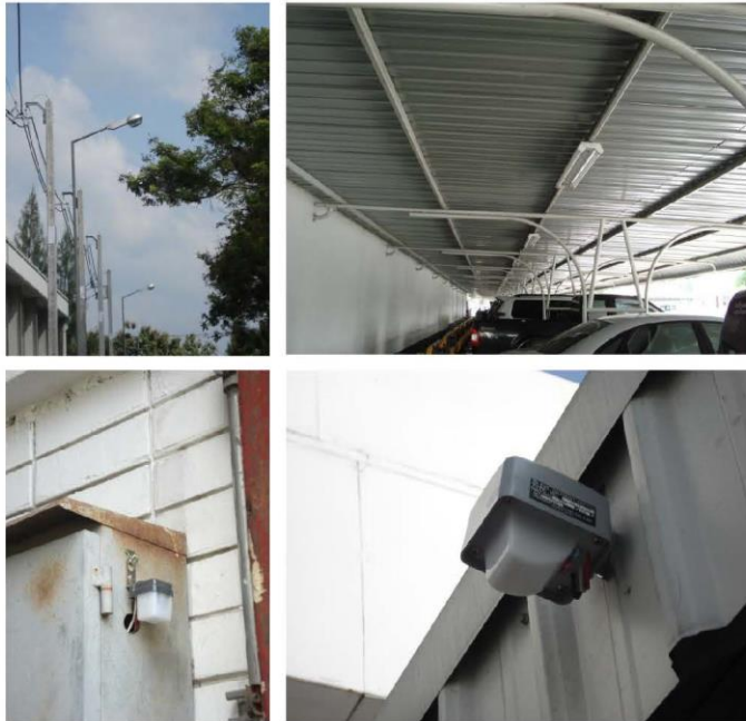
รูปที่ 3.16 การติดตั้ง Photo Switch เพื่อควบคุมแสงสว่างภายนอกอาคาร
